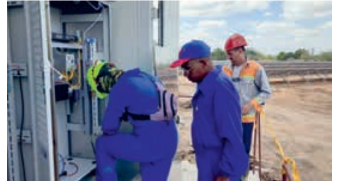
Por su incondicionalidad en la ejecución y puesta en marcha de «La Criolla», la CTC otorgó a los colectivos implicados en la tarea la bandera de Proeza Laboral.
