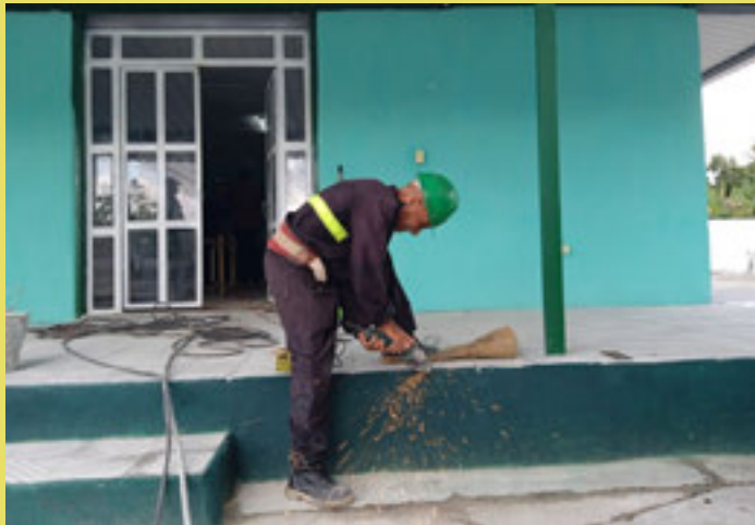
Trabajadores ultiman detalles para que pronto la casa de abuelos abra sus puertas a jubilados de Electromecánica.
